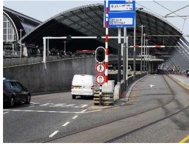
(トンネル出口)
